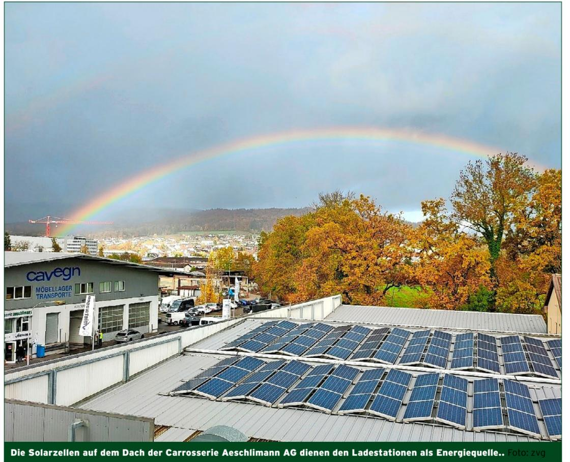
Die Solarzellen auf dem Dach der Carrosserie Aeschlimann AG dienen den Ladestationen als Energiequelle.. Foto: zvg
